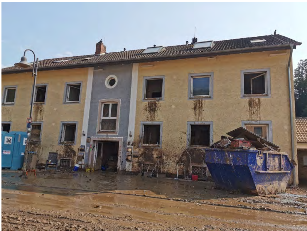
In diesem Mehrfamilienhaus haben wir den Keller ausgeräumt und abgepumpt.
