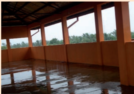
Obergeschoss ohne Fenster wurde oft nass.
