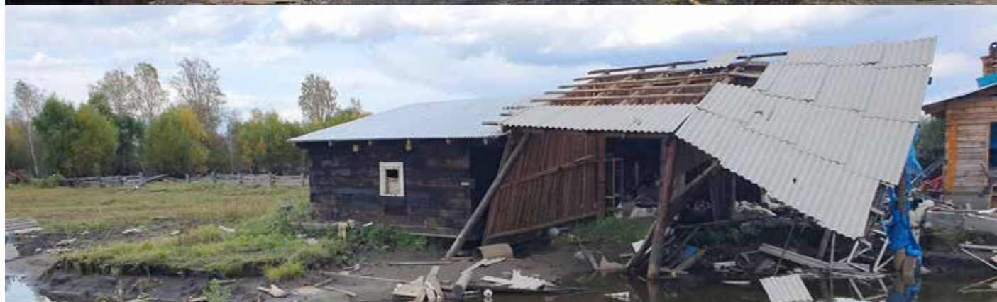
Schäden nach dem Hochwasser
